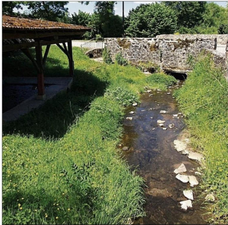
ENVIRONNEMENT. Le ruisseau de La Goutte à Saint-Jean-Ligoure va retrouver son lit originel. PHOTO MAIRIE SAINT-JEAN-LIGOURE
